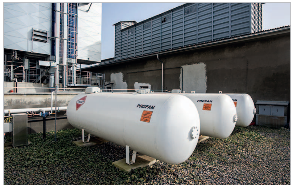
Zásobníky na kapalný propan 4,8 m 3 firmy TOME GAS
