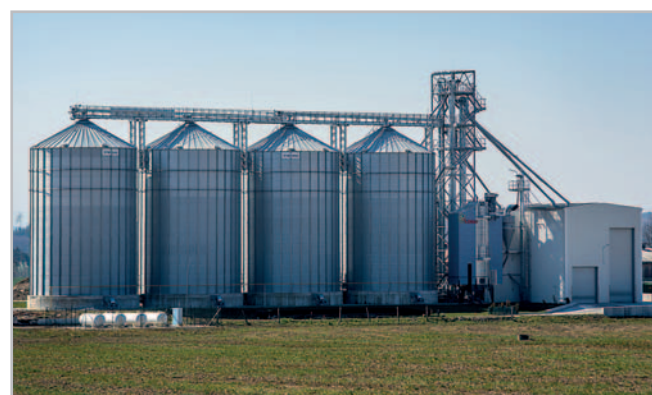
Přípojka zemního plynu byla nákladná a vše vyřešil kapalný propan Foto archiv firmy
