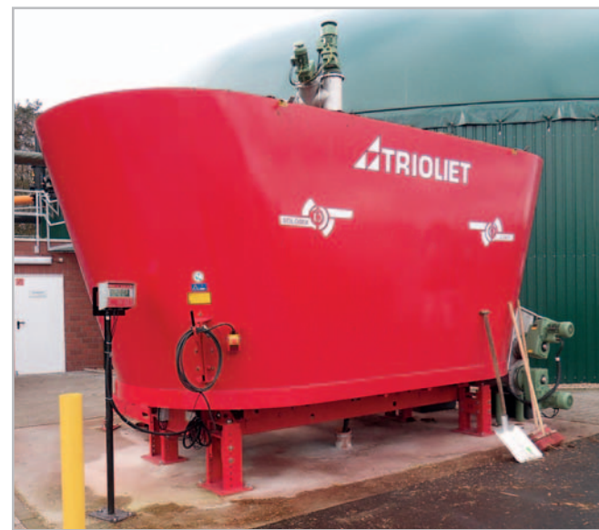
Míchací vana s vertikálními šneky jako součást plnicí technologie Foto autor
